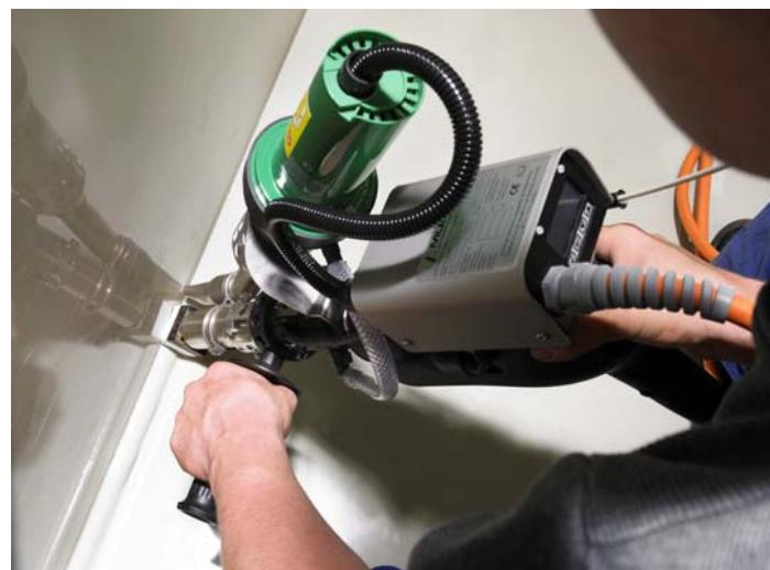
Рис.1 Выполнение сварного шва К-типа
