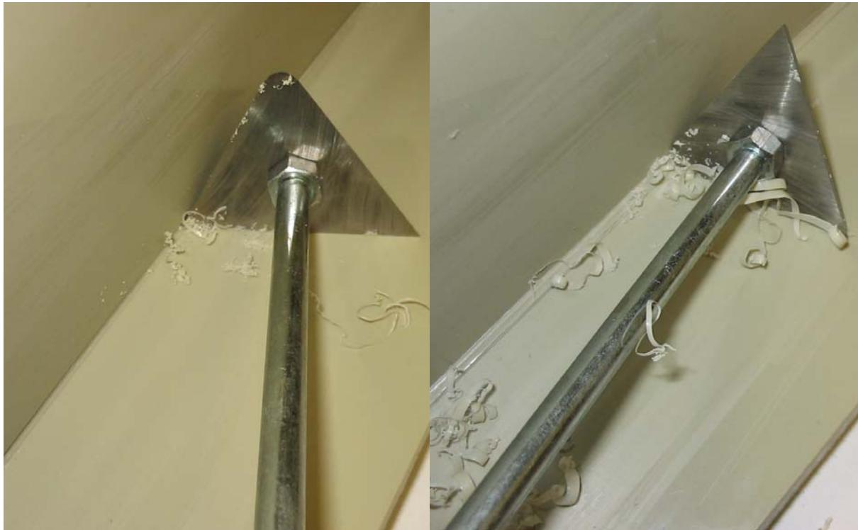
**Рис.10 Зачистка поверхностей перед сваркой шва К-типа**
